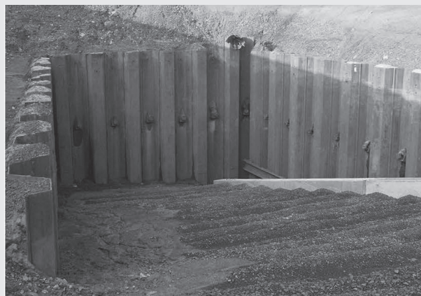
Abb. 1. Rückverankerte Spundwand
