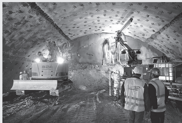
Abb. 2. Anker im Tunnelbau
